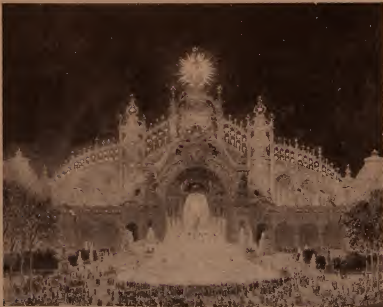
LE PALAIS DE L'ÉLECTRICITÉ ET LE CHATEAU D'EAU
